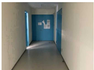
廊下上の避難障害物の有無
